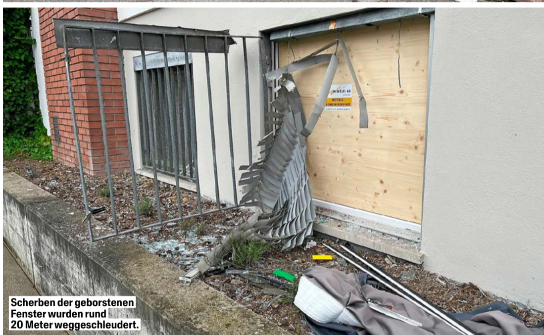
Scheiben und diverse Möbel gingen bei der Explosion in die Brüche.
